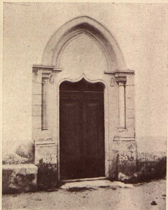
SANTA MARIA DE SINTRA — Porta lateral (sul) Estado actual
